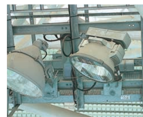
投光器アップ(2kWショートアークメタルハライドランプ)
