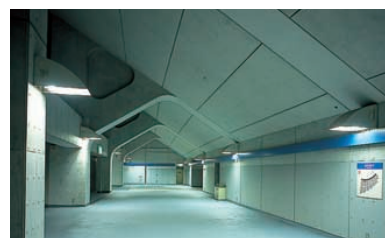
コンコースに設けられた特注ブラケット(250W,400W HIDランプ)
