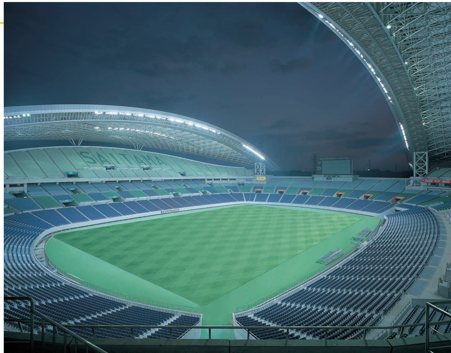
夜間点灯状況(全点灯時)：2kWショートアークメタルハライドランプ投光器152台と2kWロングアークメタルハライドランプ投光器204台による全点灯時の水平面平均照度は2,000lxが得られている(5,550K, Ra:89)
