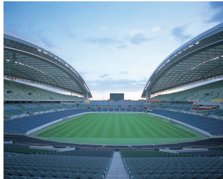
北方向から西方向を望む夜間の状況・2羽の白鷺をイメージした形の屋根にはキール部分に横一列に投光器が並び、シンプル形状で納められている
