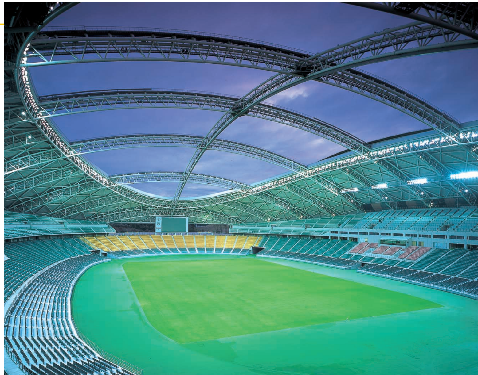
陸上競技全点灯時：各照明架台の上段には高効率形ロングアークランプ器具を基本に、下段は高演色形のショートアークランプ器具およびロングアークランプ器具の2種類を設置している
