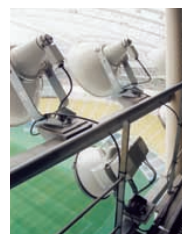
器具設置の状況：フィールド照明は、固定屋根先端のアーチフレームとセットバックした照明架台上に上下2段の直線配置としている
