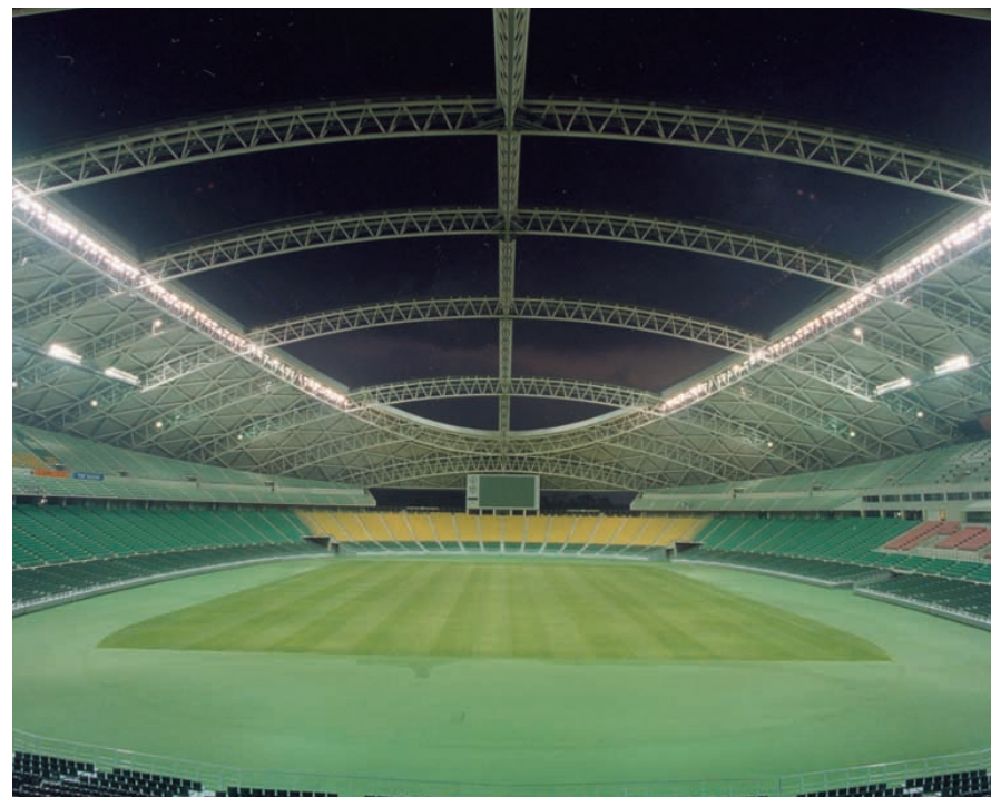
サイドスタンドから望む陸上競技全点灯時の照明状況：水平面照度、鉛直面照度、Raの基準を満足しており、ハイビジョン放送に適している
