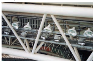
器具設置の状況：フィールド照明は、固定屋根先端のアーチフレームとセットバックした照明架台上に上下2段の直線配置としている
