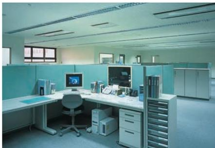
設計室の照明：Hf32W2蛍光ランプOA対応埋込器具を連結設置している
