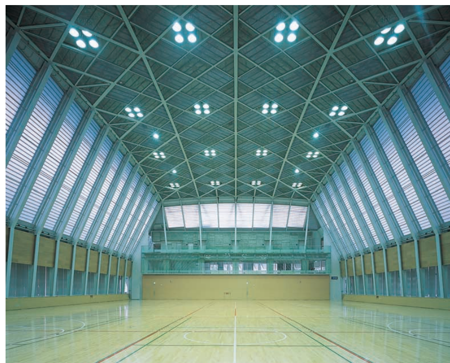
64m x 46mの広さをもつサブアリーナ：700W高効率メタルハライドランプバックライト器具と1kW高効率メタルハライドランプ照明可変器具を設置
