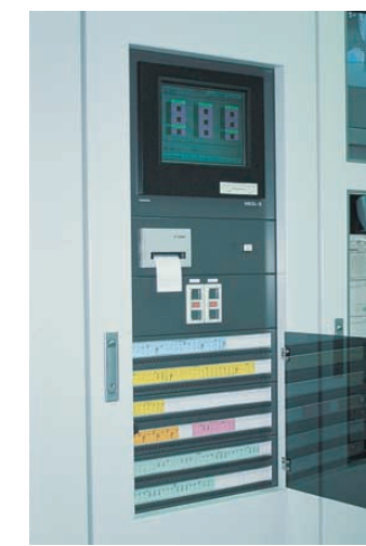
事務所に設けられている照明主操作盤
