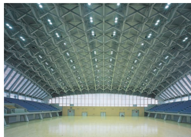
メインアリーナの天井面：照明制御主操作卓及び壁スイッチにより競技レベルに合わせてパターン制御している
