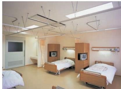
病室(4人部屋)の照明：全般照明に32W Hf蛍光ランプ2灯用埋込器具を採用し、各ベッドに処置灯、ベッド灯を設置。
