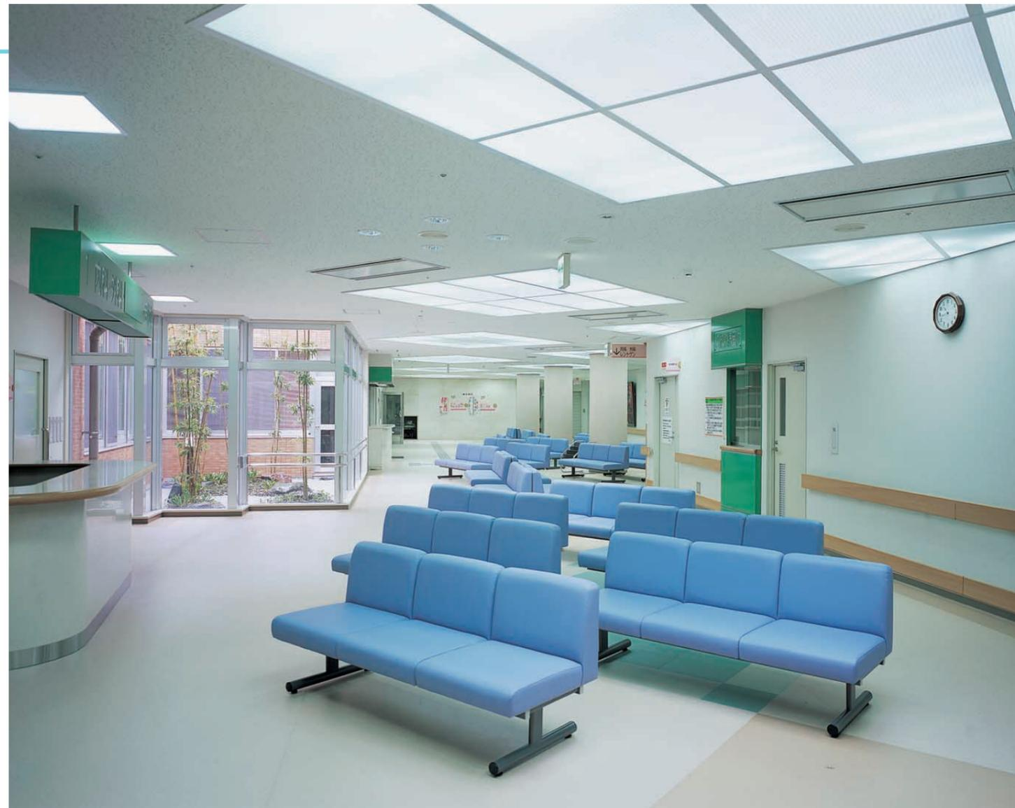
光庭を配した待合ホールの照明：大きなトップライトの内部に32W Hf蛍光ランプ笠なし器具を設置。自然採光と人工光により、省エネをはかりながら安らぎ感、くつろぎ感を高めている
