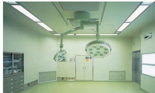
手術室の照明：4灯用クリーンルーム用器具を口の字形に連結配置している
