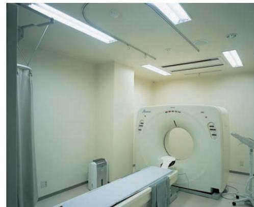
CT撮影室の照明：32W Hf蛍光ランプ2灯用埋込器具の調光タイプ(25~100%)を設置
