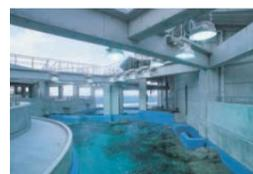
水面上部から下方向照射しているメタルハライドランプ投光器
