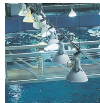
水槽部まで光が行き渡るよう広角形投光器を前面に配置し、下方向に照射
