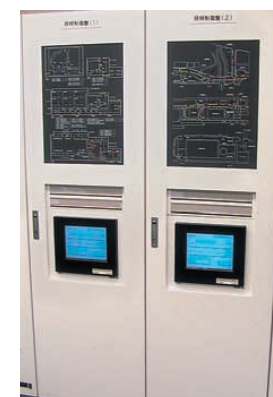
照明主操作盤
