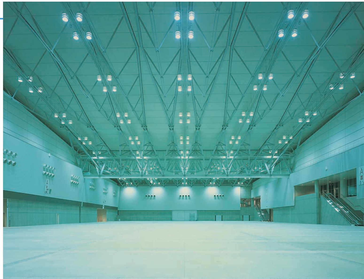
展示ホールの全点灯時の照明：1kW高効率メタルハライドランプバンクライトを採用。照明制御システムにより展示会や各種興行に合った照明点灯を可能にしている
