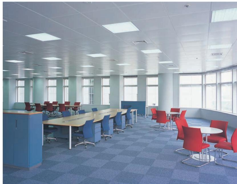
オフィススペース：照明、空調吹出口、スプリンクラーなどを内蔵した独立スチールパネルを格子状にセットしたグリッド天井を採用
