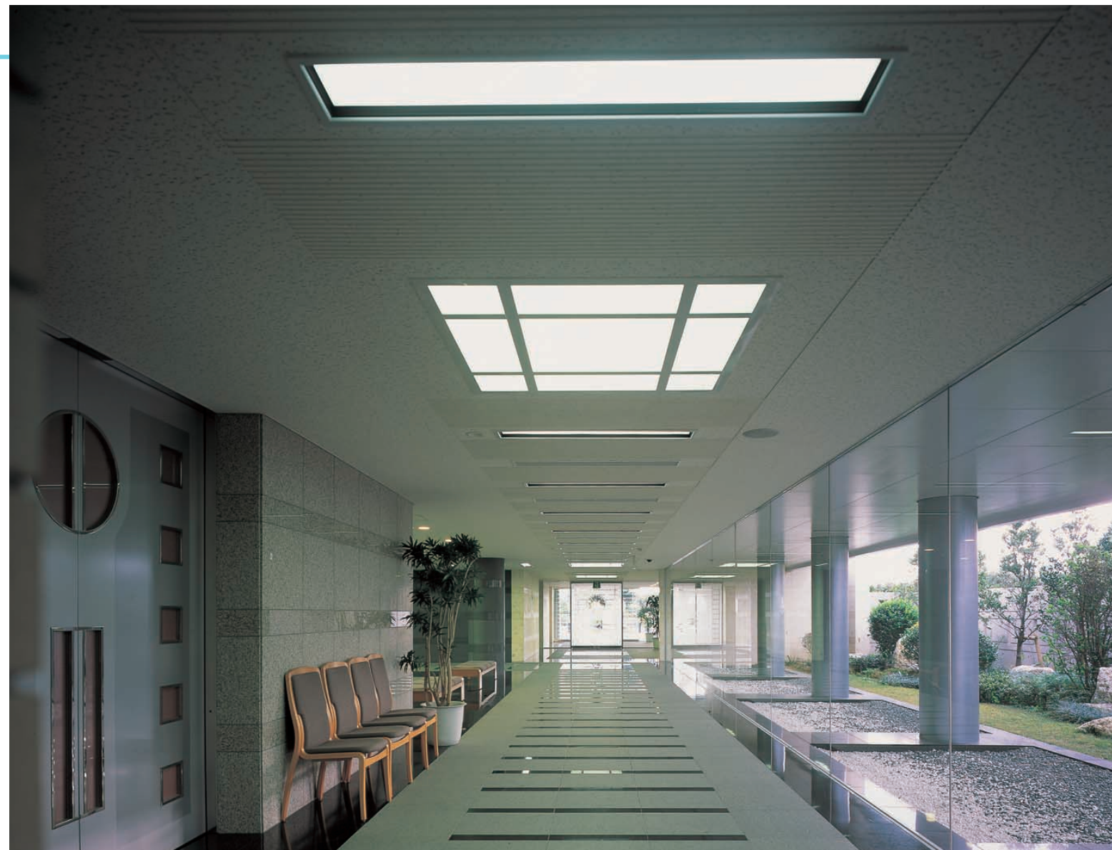
玄関ホール側から告别室側を望む廊下の照明：床面のデザインに合わせてHf蛍光ランプ埋込形深枠乳白カバー付照明器具を使用
