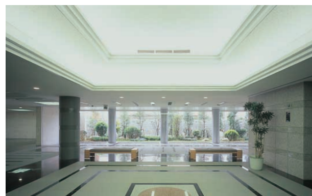
告别ホールの照明：天井中央には間接照明を、下がり天井面にはダウンライトを配置し、光庭から昼光を取り入れている
