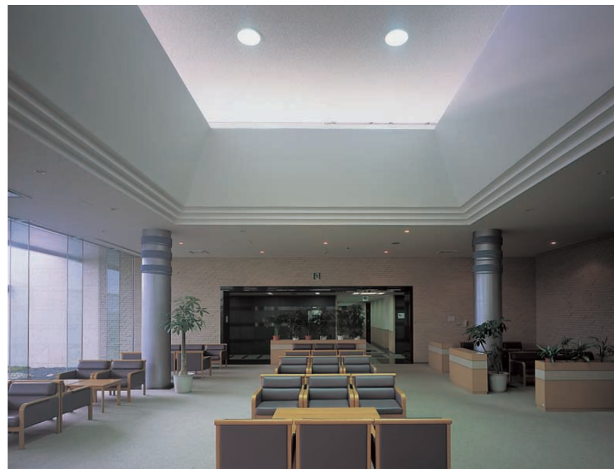
待合ロビーの照明：ダウンライトを常時点灯させ、高天井用器具は通常の晴天時は消灯し、高天井用器具の側面から昼光を取り入れ照度を確保している
