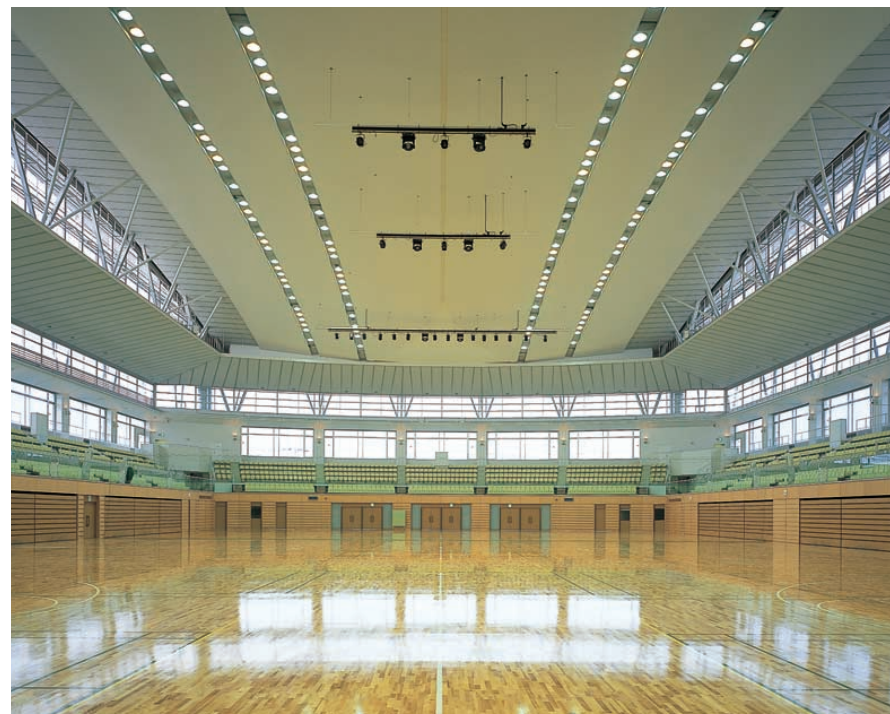
メインアリーナ(1)：天井高さまでの窓とライトシェルフを設け、自然光を効果的に採り入れている。1kWメタルハライドランプ132台と660W高圧ナトリウムランプ54台の埋込ダウンライトを設置
