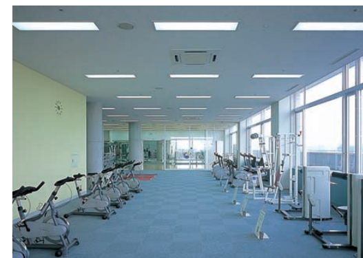
トレーニング室：Hf32W3灯用埋込器具(アクリルカバー付)を54台設置。十分な明るさを確保しながら、まぶしさを軽減し、かつ省エネがはかられている
