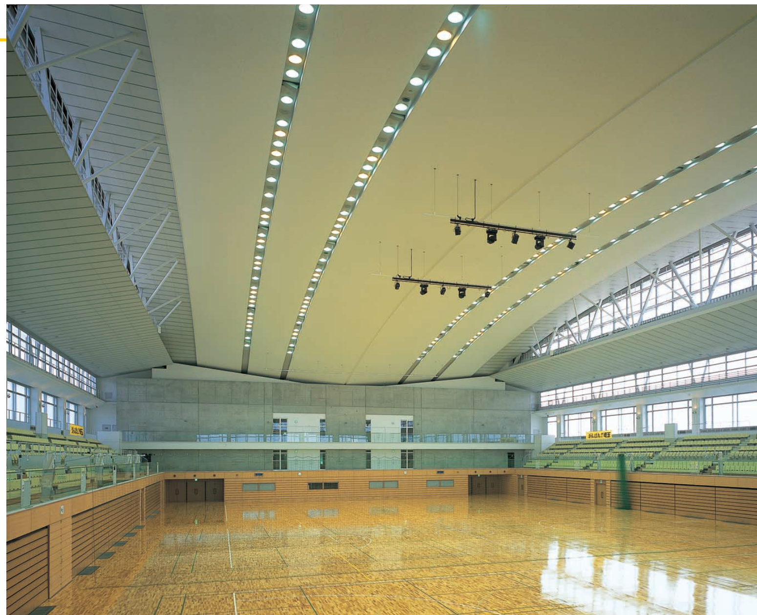
メインアリーナ(2)：4列の天井スリット内に収められている埋込ダウンライトは、2線式多重伝送システムを採用した照明制御で、アリーナ面を効率よく照らし、競技レベルに応じたパターン点灯を可能にしている
