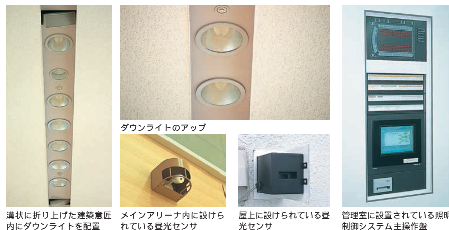
メインアリーナ(1)：天井高さまでの窓とライトシェルフを設け、自然光を効果的に採り入れている。1kWメタルハライドランプ132台と660W高圧ナトリウムランプ54台の埋込ダウンライトを設置
