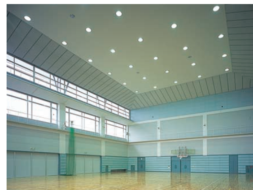
サブアリーナ：1kWメタルハライドランプ電動昇降式ダウンライト35台を整理配置
