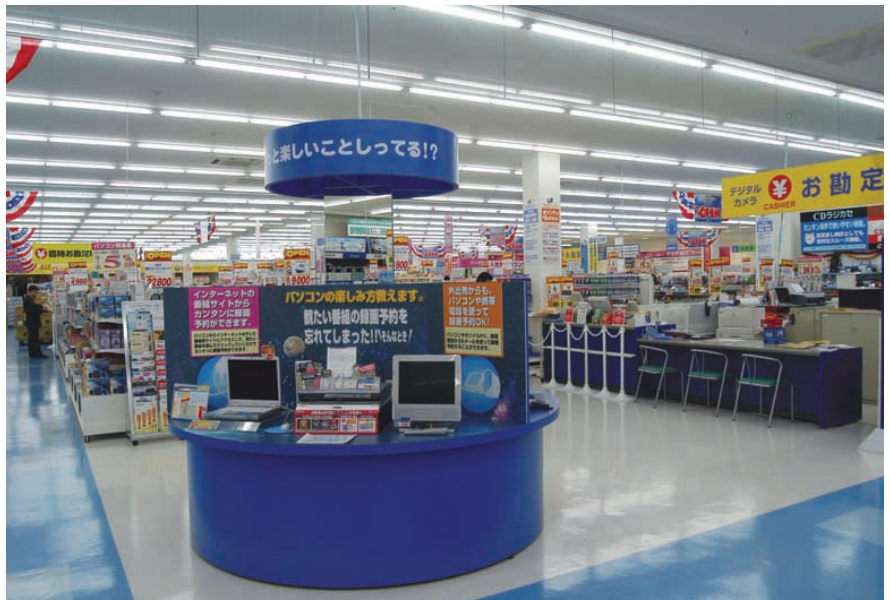
105WHfコンパクト形蛍光ランプ直付連結器具をライン配置。生き生きとした活気ある商空間を創り出している
