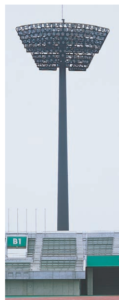
器具設置状況②(照明塔No.3)
