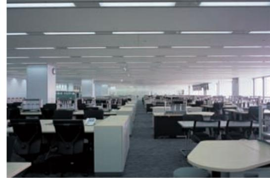
人感センサによる不在時の減光制御時の高層階オフィスエリア
