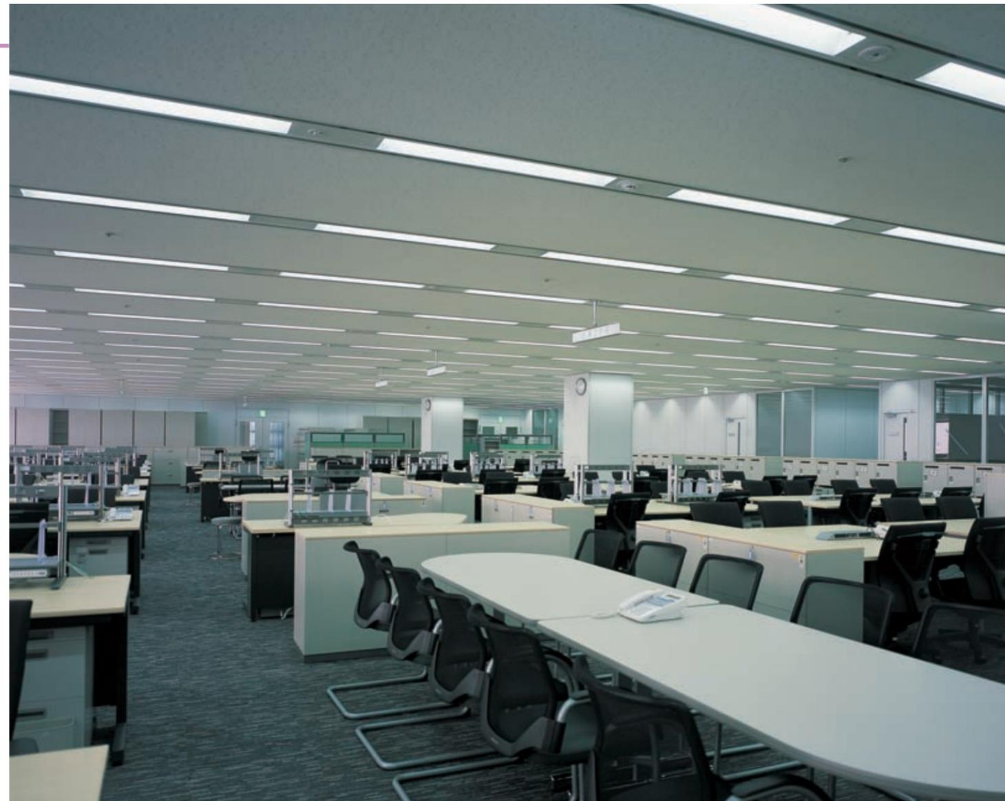
高層階オフィスフロアの照明: 3.2m×3.2mのシステムモジュールで構成され、照明は32WHi蛍光ランプ1灯用埋込器具を採用。(窓側に昼光利用制御、インテリア側に適正照度制御、さらに不在時に減光制御を行っている)
