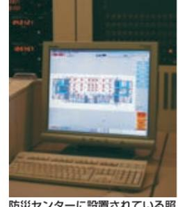
防災センターに設置されている照明センター装置: 全館の照明制御・監視及び照明電力のモニタリングが可能
