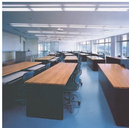
教室の照明：グレアカットした学校専用器具を採用
