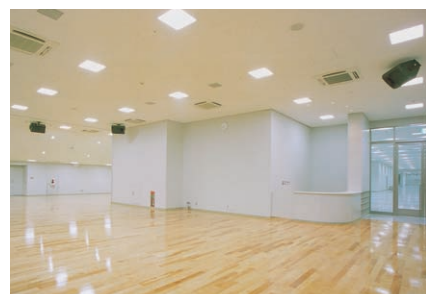
トレーニングルーム：埋込カバー付器具により、明るくかつグレアを抑えた快適な照明空間となっている
