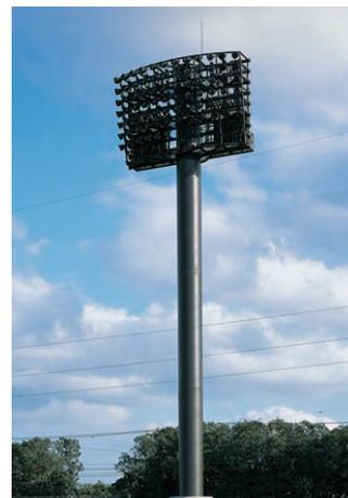
照明塔6基(最大取付高さ37m)に投光器528台を設置
