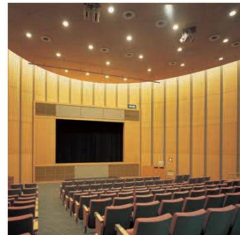
視聴覚ホールの照明：32Wコンパクト形蛍光灯ラフ2灯用ダウンライトと間接照明の組合せを採用。調光により照明シーンを展開
