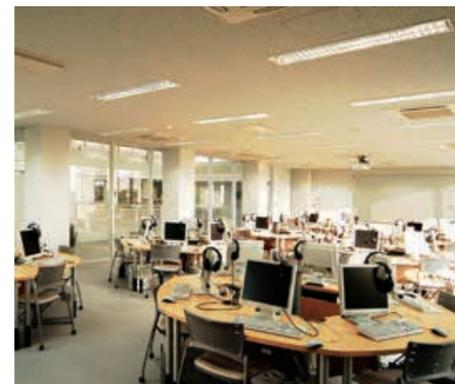
コンピュータ室の照明：バツフル付HF埋込器具を整列配置
