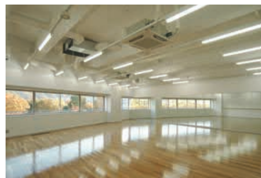
舞台表現実習室の照明：HF32W1灯用トラフを3.15mピッチでレースウェイに設置
