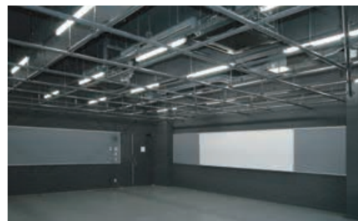
舞台照明実習室のHF32W1灯用トラフをレースウェイに設置したベース照明：部屋全体を黒色塗装し舞台照明の色、光の広がり効果を演習
