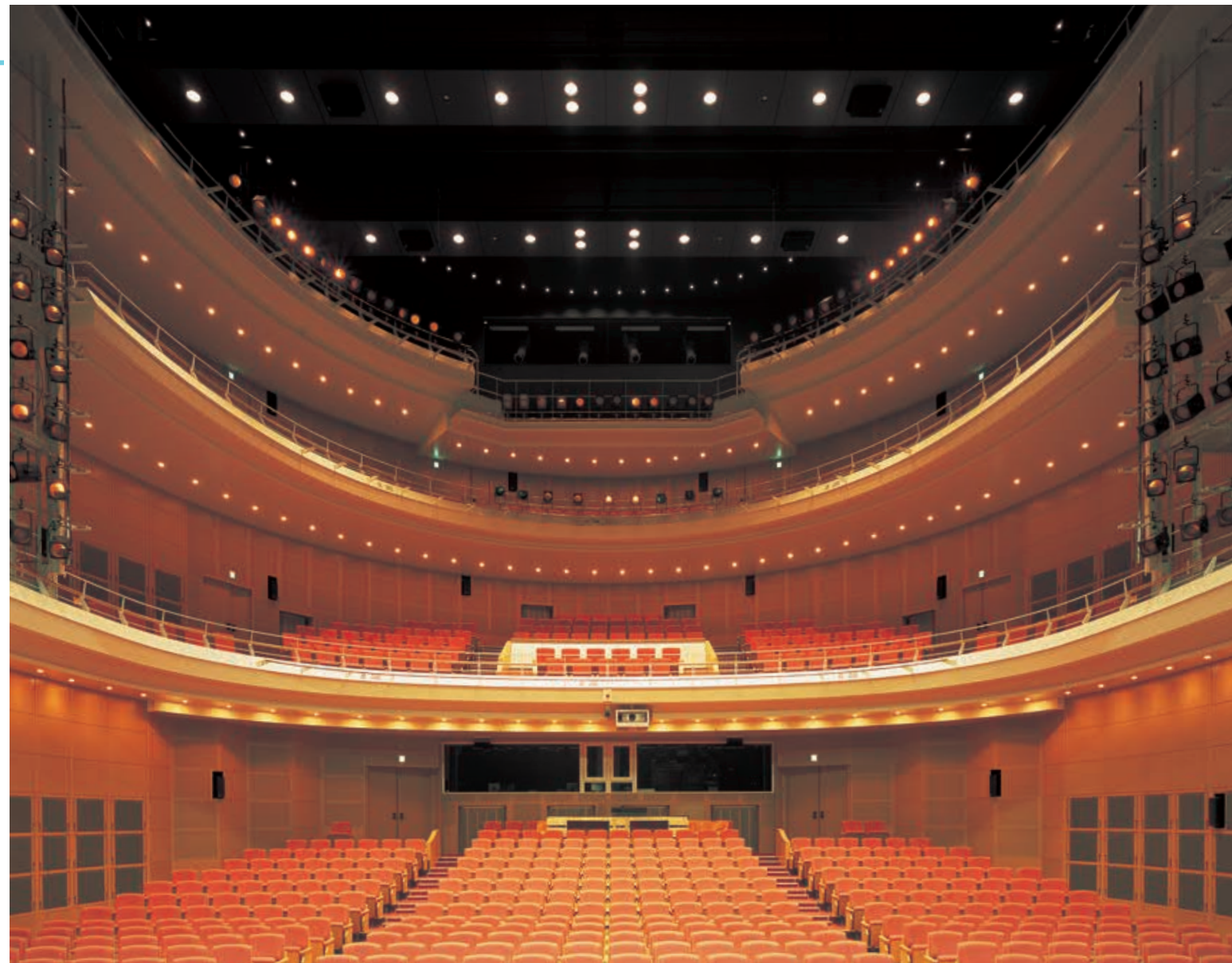
劇場内客席の照明：ベース照明は16m上部のキャットウォーク下部に点灯でのトラブルがないようハロゲンランプ(500W)ダウンライトを設置
