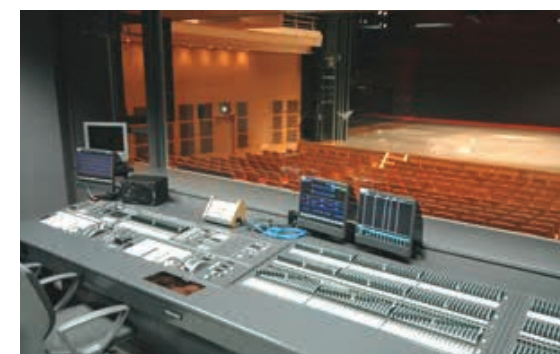
調光室から客席を望む：調光操作卓はデジタル伝送方式を採用。左側がメモリー卓、右側がプリセット卓
