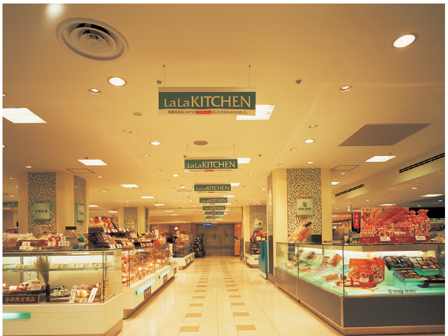
八丁堀本店 地階食料品フロアのお菓子売場の照明：100Wセラミックメタルハイドランプ(ネオセラ)ダウンライトを採用
