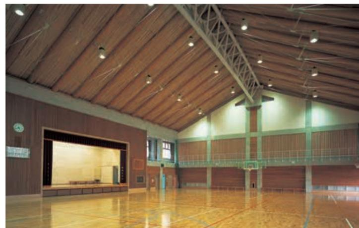
中学校の屋内運動場：照明は400Wメタルハイドランプバンクライト(電動昇降装置内蔵)を左右対称に分散配置
