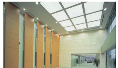
5階受付ラウンジの照明：40W蛍光ランプ特注器具と42Wコンパクト形蛍光ランプダウンライトを配置
