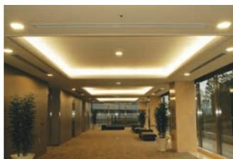
5階オフィスロビーの照明：32WHf蛍光ランプ間接照明と42Wコンパクト形蛍光ランプダウンライトを使用
