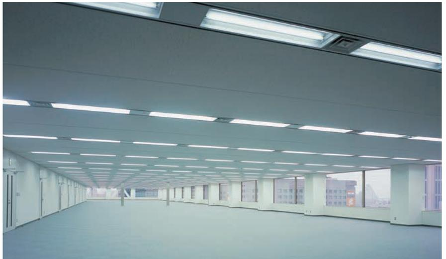
基準階オフィスの照明：フレキシビリティの高いシステム天井を採用し、設備ラインには32WHf蛍光ランプ2灯用埋込器具を設置
