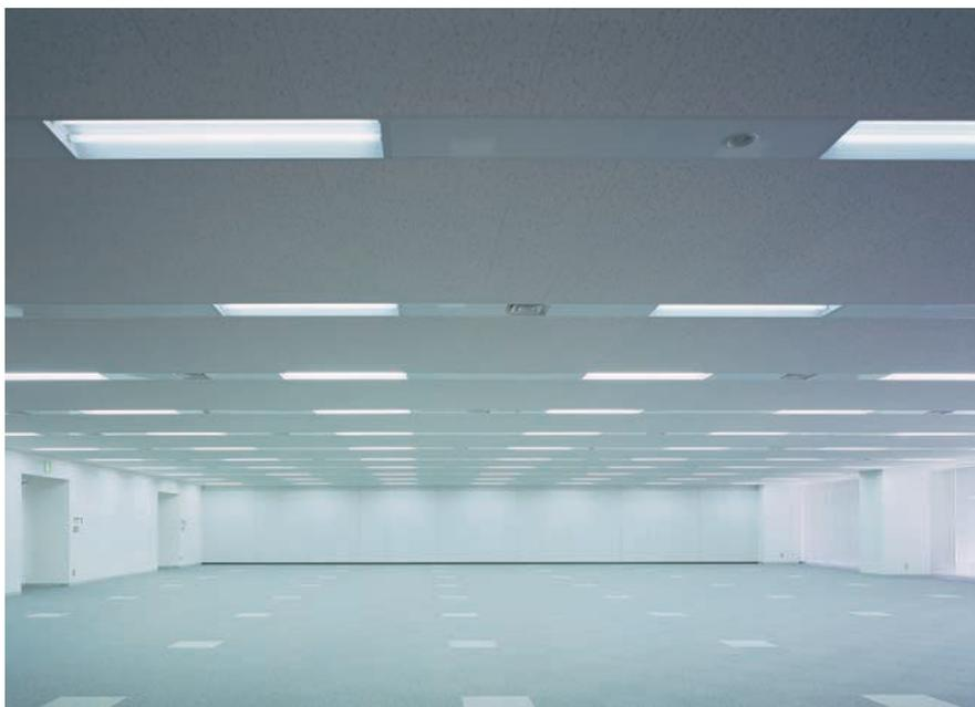
オフィスフロアの照明：システム天井に空調リターン付32WHf蛍光ランプ2灯用埋込器具を設置
