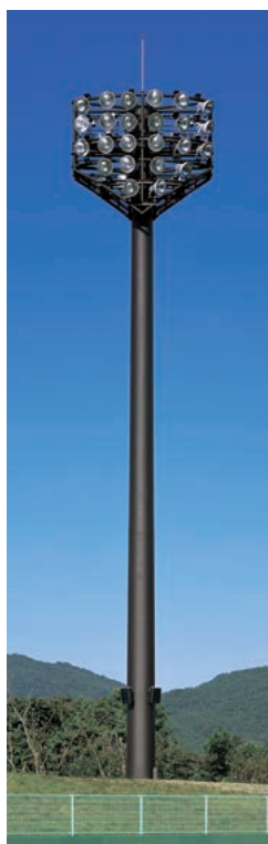
照明塔：照明架台にはHID投光器24台を設置
