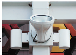
投光器(CDM70W)とブラケット(FLD27W)
