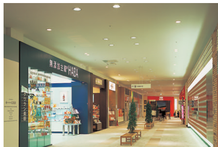
リビングエリア通路の照明：42Wコンパクト形蛍光灯ランプダウンライトとCDM70Wユニバーサルダウンライトを配置
