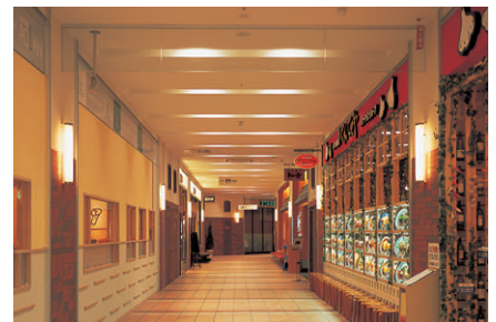
レストランエリア通路の照明：スリットライン内にCDM70Wダウンライトを2台ずつ設置
