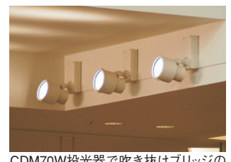
CDM70W投光器で吹き抜けブリッジの天井面を照射。賑やかさを表現
