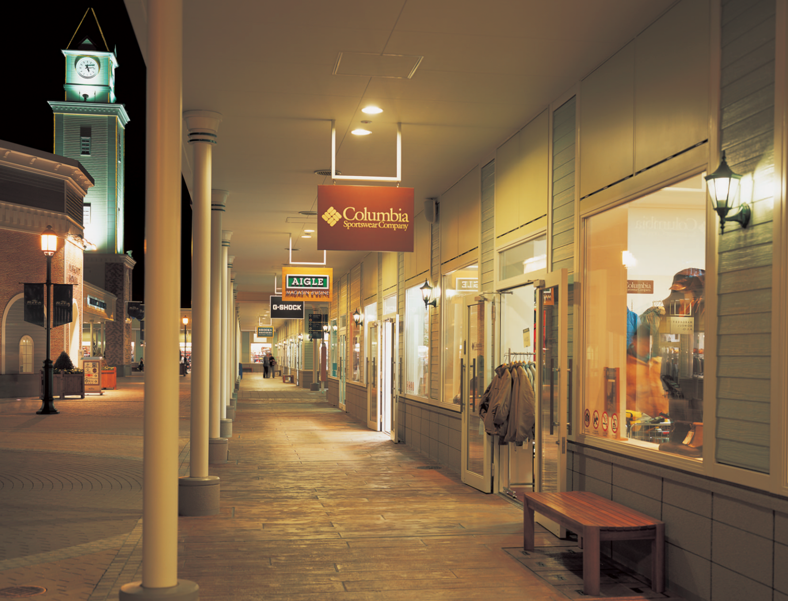
半屋外の回廊：各店舗の外壁にガス灯をイメージした壁面ブラケットを採用。天井面には42Wコンパクト形蛍光ランプ2灯用ダウンライトを設置（写真はアウトドア・スポーツエリア）
