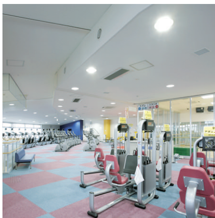
マシジムの照明：42Wコンパクト形蛍光ランプダウンライトを中心から放射状に配置
