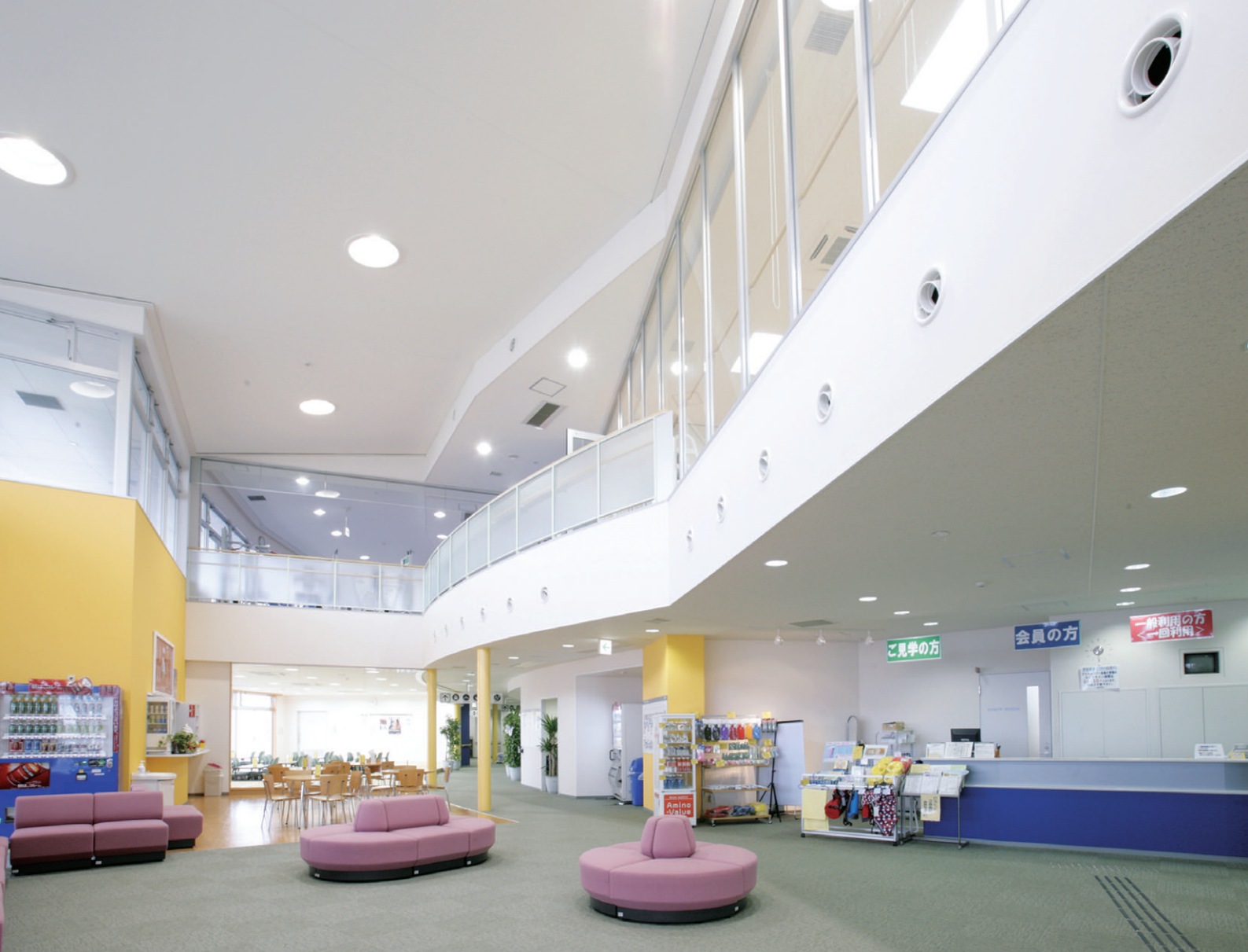
ロビー・閲覧コーナーの照明：吹き抜け部には400Wメタルハイドランプダウンライト（オートリール付）を使用。閲覧室や受付には32Wコンパクト形蛍光ランプダウンライトを配置
