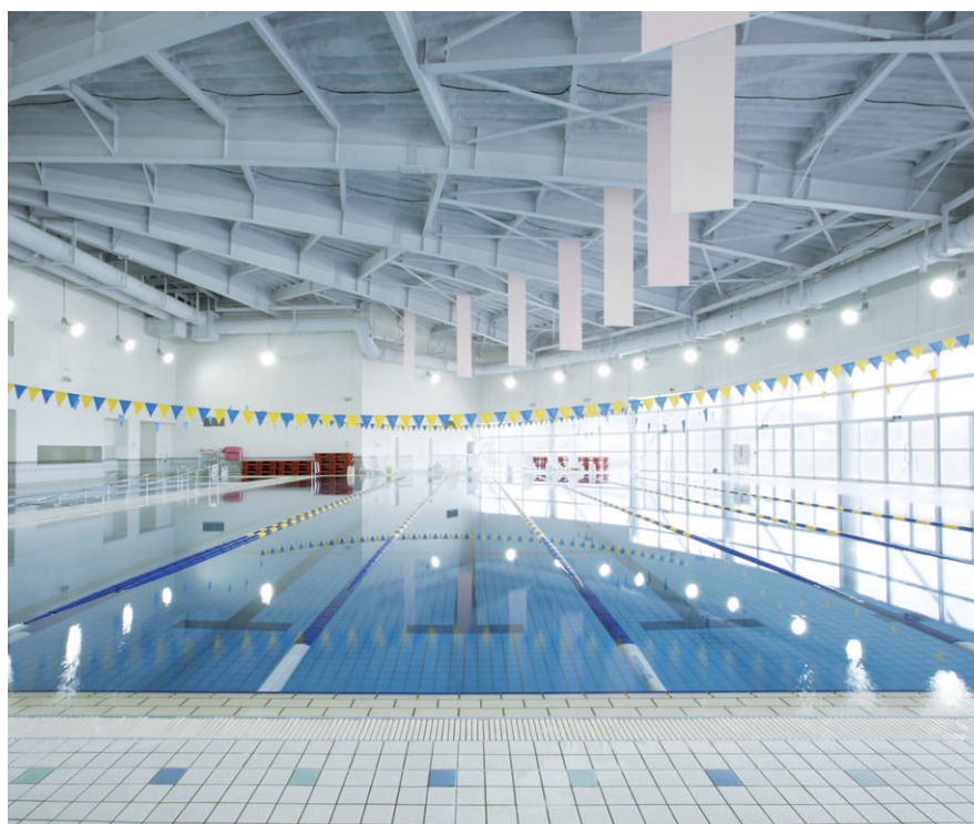
屋内温水プール(25m×8コース)の照明：700W高効率メタルハイドランププール専用サイドライティング器具を壁面上部に設置
