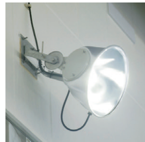
プール専用サイドライティング器具(前面ガラスにはテフロン膜加工)
