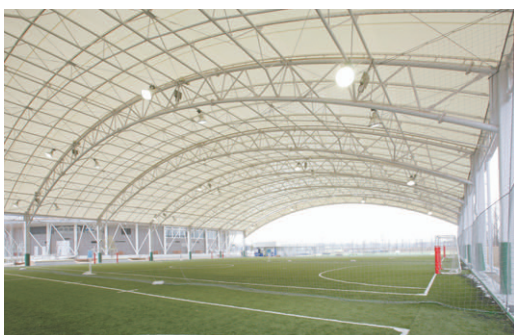
フットサル場の照明：1kWメタルハイドランプガード付投光器を各サイドライン上部のトラスに設置
