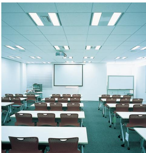
研修室の照明：グリッド天井システムスクエア器具により適正照度を確保しつつ、遮光角30°のバツフルでグレアカット
