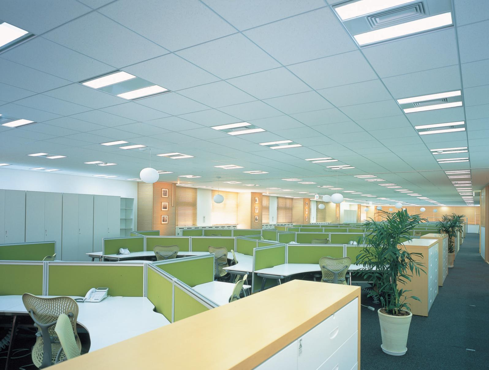
5階オフィス大フロアの照明：7.2m天井モジュールにグリッド天井システムスクエア器具連続調光形を採用し、照度センサで初期照度補正制御と昼光利用適正照度制御を行っている
