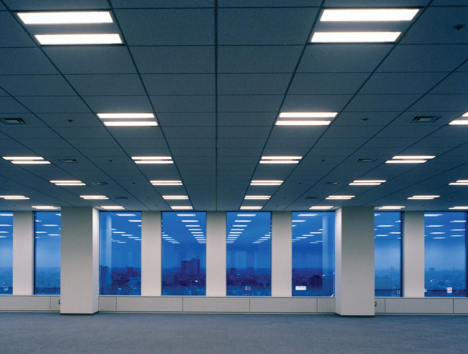
基準階オフィスの照明：グリッド天井システム対応の45WHfコンパクト形蛍光ランプ2灯用調光器具により、室内のレイアウト変更にもフレキシブルに対応可能
