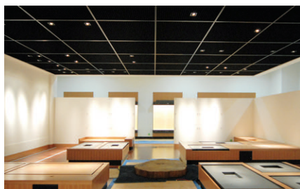
総合展示室の照明：ハロゲンランプユニバーサルダウンライトを中心に設置。壁面の展示ケースには美術館・博物館用Hf蛍光ランプ埋込器具調光形ルーバ付を採用
