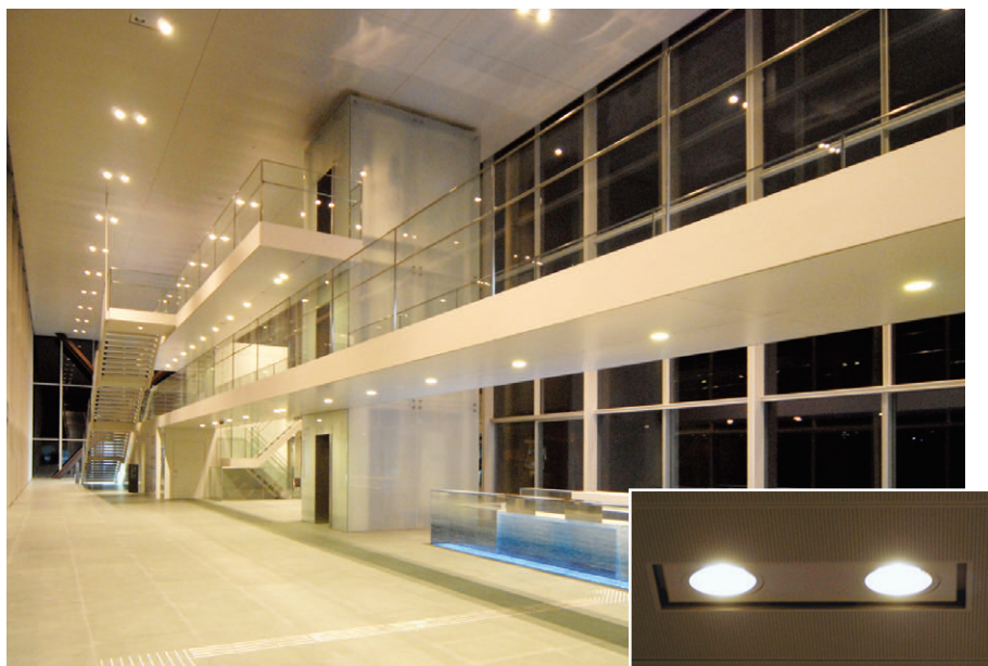
エントランスロビーの照明：メタルハライドランプ特注ダウンライト(電動昇降装置付)を2台1組にして設置
