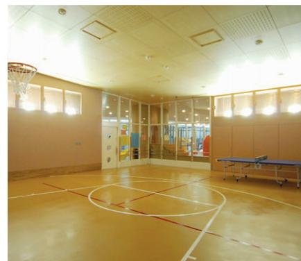
遊戯室の照明：壁側からのアップライトで天井面を照らし、柔らかな間接照明としている
