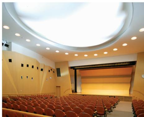
たまごホールの照明：たまご状の天井からは両側壁に内蔵したアップライトにより親しみ感を表出、その周辺には調光形ダウンライトで用途に対応した明るさを確保
