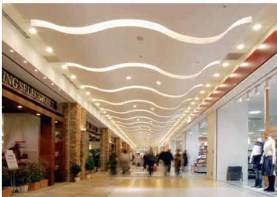
1階通路：波形天井のスリット内にライン照明を施し、中央にHIDユニバーサルダウンライト(MT100W)、店舗側に蛍光灯ダウンライト(FHT42W)を配置
