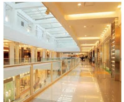
インナーモール通路の照明：直線ライン照明を中心に中央にHIDユニバーサルダウンライト、店舗側に蛍光灯ダウンライト(FHT42W)、柱には横溝状に光を描く建築化照明を配置
