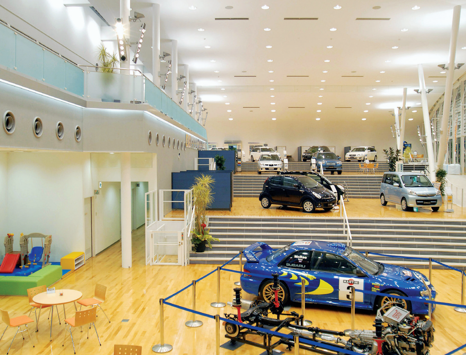
新車ショールームの下端方向から上段を望む：ベース照明にHID埋込ダウンライト (MF400W) を多用し、車の魅力的なデザイン、光沢の質感を効果的に表現
