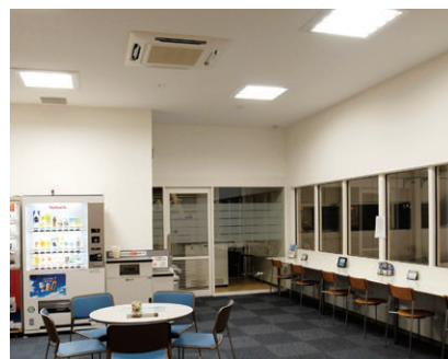
サービス待合スペースの照明：薄形直付スクエア器具（FHP45W×4）を採用し、愛車の整備状況を見ながら待ち時間をゆったり過ごせる光環境を形成
