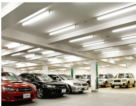
屋内中古車ショールームの照明：32WHf蛍光ランプ笠なし器具を採用。天井も明るく、自然な色合いで車を引き立てている
