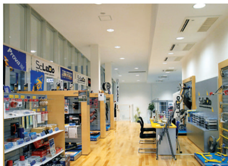
各種用品コーナーの照明：蛍光灯ダウンライト（FHT42W×3）を配置
