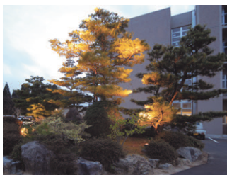
樹木のライトアップ（ハロゲン投光器3台を使用）
