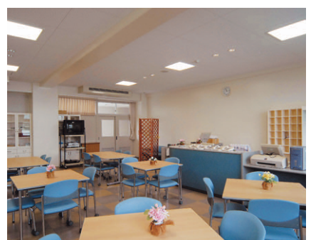
ビジネス実習室の照明：ベースに4灯用スクエア器具を設置。白熱灯ダウンライトで演出照明
