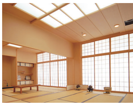
和室の照明：蛍光ランプトラフを内蔵した光天井風とし、白熱電球ダウンライトで暖かな雰囲気を創出
