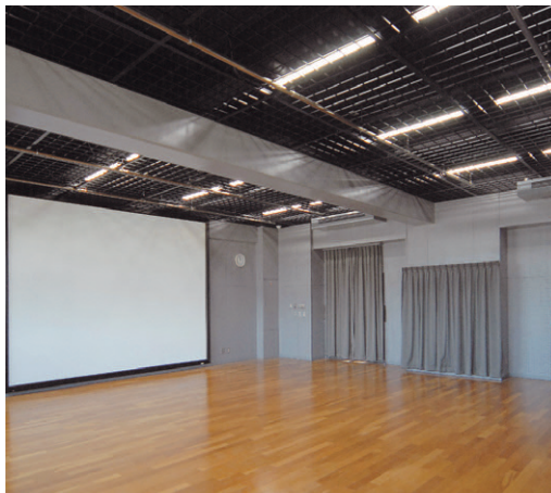
マルチメディア実習室の照明：黒色塗装したメッシュ天井内に2灯用反射笠器具（黒色）を採用
