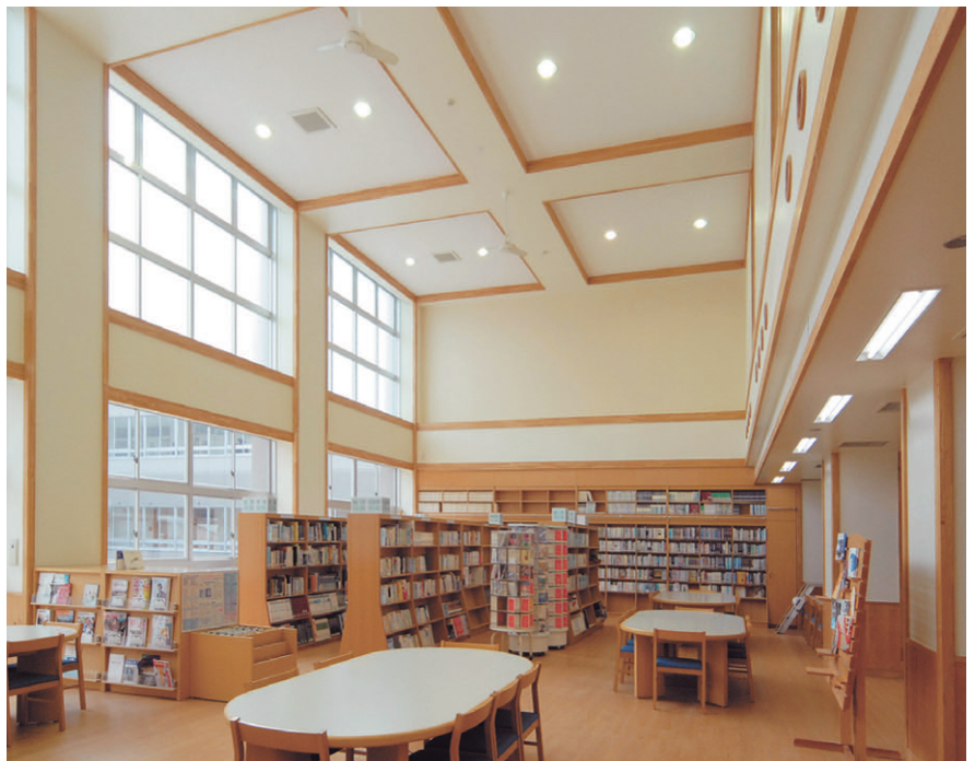
図書室の照明：250Wメタルハライドランプダウンライト(電動昇降装置付)を均等配置
