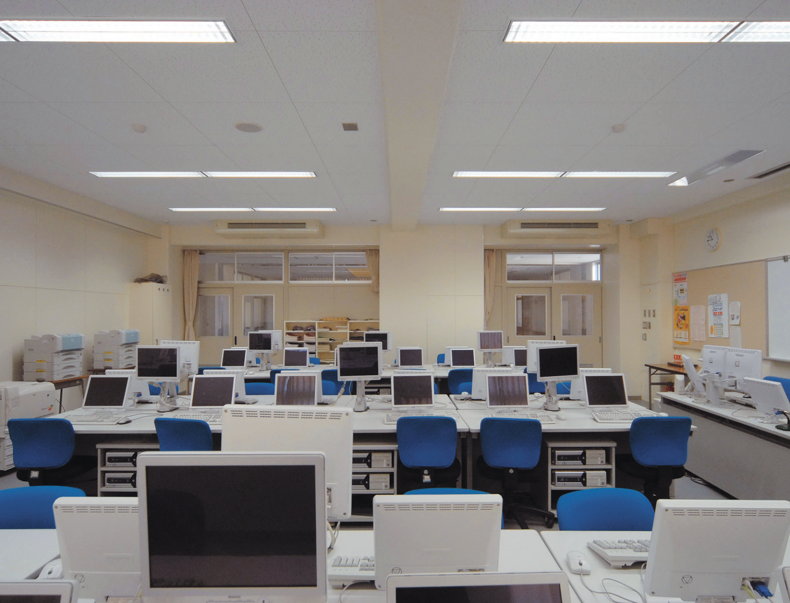
コンピュータ室の照明：32WHf蛍光ランプ2灯用埋込器具OAルーバ付2連結を均等配置。目の負担を軽減した光環境を形成
