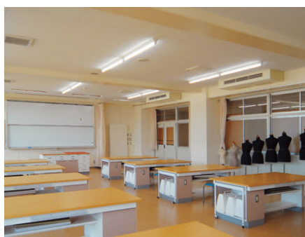
被服家庭介護実習室の照明：Hf逆富士形器具を配置。空間全体を輝度差の少ない光環境とし目の疲労を軽減
