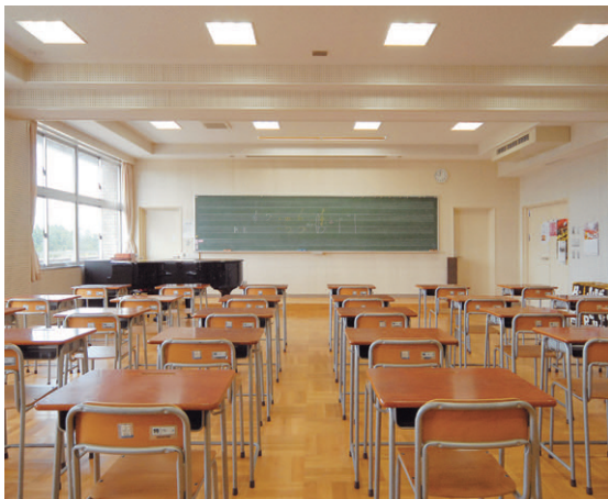
音楽室の照明：スクエア器具を使用し、演出上のレイアウト変更に柔軟に対応
