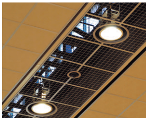
メインアリーナに採用されている1kWメタルハライドランプダウンライト(MF1kW)
