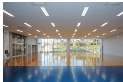
蛍光灯埋込器具(FHF32WX2)を均等配置したトレーニングエリアの照明
