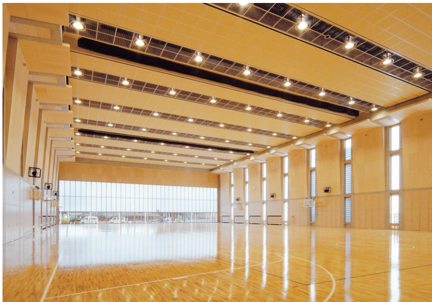
メインアリーナの舞台側から正面を望む：1kWメタルハライドランプ埋込ダウンライトをメッシュのスリット天井へライン状に配置
