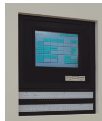
照明制御装置
