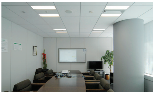
オフィスフロア会議室の照明：照度センサと蛍光ランプとの自動調光の連動により机上面照度を一定に保ちながら消費電力を抑制
