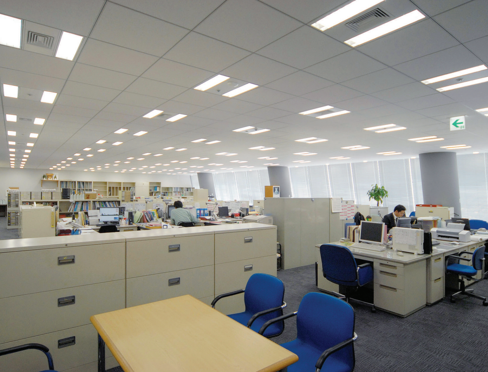
オフィスフロア高層階ゾーンの照明：600mm角モジュールのグリッド天井の設備ユニットには照明器具のほか、空調吹出口、スプリンクラーヘッドなどを集約設置
