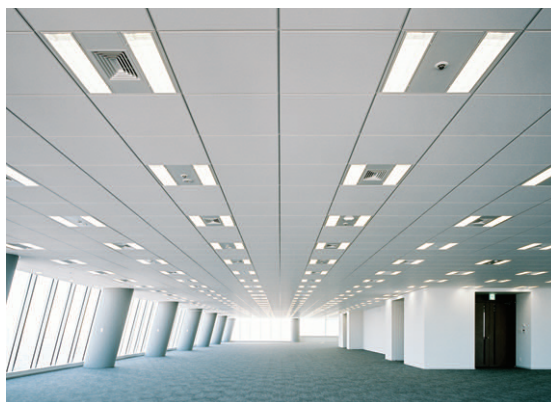
オフィスフロアの照明：ワンフロア約1,500㎡から名古屋地区最大の約2,200㎡を確保。照明はグリッド天井システム対応45Wコンパクト形蛍光灯2灯用調光器具(ハの字ルーバ付)を採用
