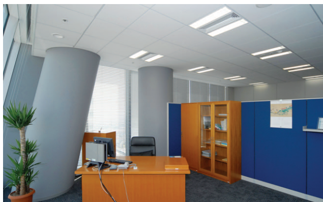
オフィスフロア役員室の照明：600mm角のグリッド天井システムの採用によりフレキシブルな間仕切りが可能
