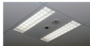
グリッド天井用45Wコンパクト形蛍光灯2灯用調光器具(照度センサを設備プレートに設置)
