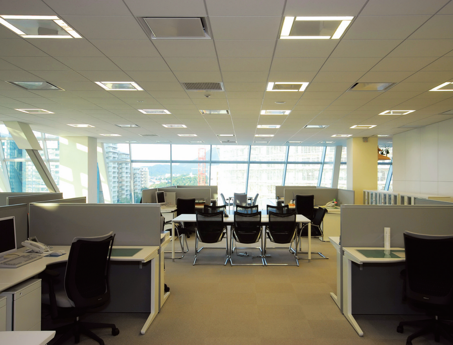
6階オフィスの照明：グリッド天井システム対応照明器具ルーバ付 (FHG70W ネオグリッドスクエアタイプ600mm) を採用。照度センサによる照明制御は6系統／フロア
