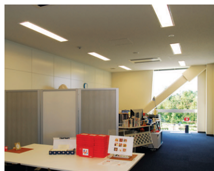
2階インキュベーション室の照明：32WHf2灯用埋込器具(システムアップ)を採用
