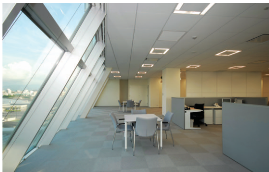
ガラス張り傾斜カーテンウォール周辺の打合せコーナーのグリッド天井システム器具 (ネオグリッド) による照明
