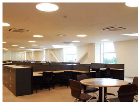
3階大学の研究室の照明：環形蛍光ランプ丸形埋込器具カバー付(グレースペースライト)を分散配置
