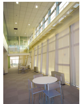
6,7階吹抜け空間の照明：150Wセラミックメタルハライドランプダウンライトを設置
