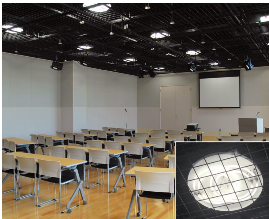
1階ホールの照明：丸形ベースライト(FHC27W+FHC34W)を均等配置
