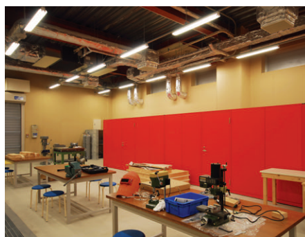
1階工作室の照明：レースウエイに反射笠器具(FHF32W×2)を設置。精密作業に十分対応できる明るさを確保
