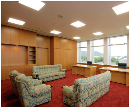
議長室の照明：45Wコンパクト形蛍光ランプ4灯用埋込器具調光形乳白カバー付を採用
