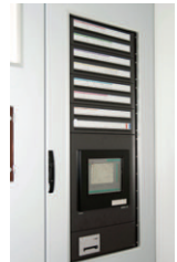
照明制御システム主操作盤（MESL-S）
