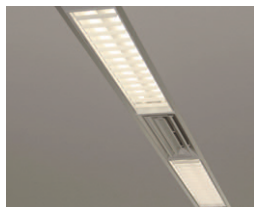
事務室に採用したシステム天井用器具
