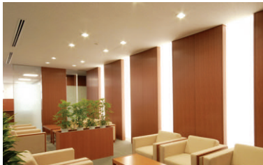
打合せコーナーの照明：天井に32Wコンパクト形蛍光ランプダウンライト、壁面は間接照明
