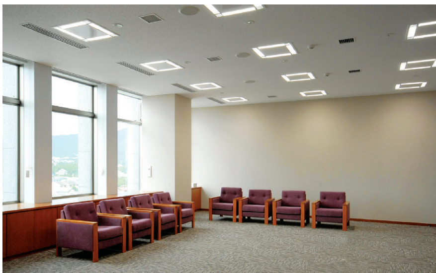
会派室の照明：間仕切り変更にフレキシブルに対応する70WT5スクエア形器具(ネオスクエア一般天井器具)を採用。照度・人感センサとの連動により、初期照度補正や在・不在によるON・OFF制御
