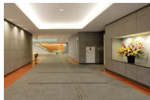
1階通路の照明：間接照明と壁面に蛍光灯ダウンライトを配置
