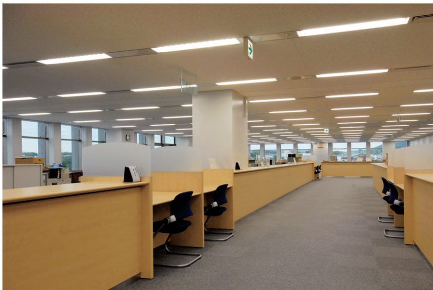
3階市民エリア(総務部・消防本部)事務室：32WHf蛍光灯システム天井用器具調光形バツフル付を採用。照度センサと照明主操作盤(MESL-S)との組合せで余剰な明るさをセーブしつつ、適正照度を維持制御
