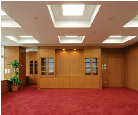
市長室の照明：折り上げ天井に45Wコンパクト形蛍光ランプ4灯用埋込器具調光形（下面乳白カバー付）を配置
