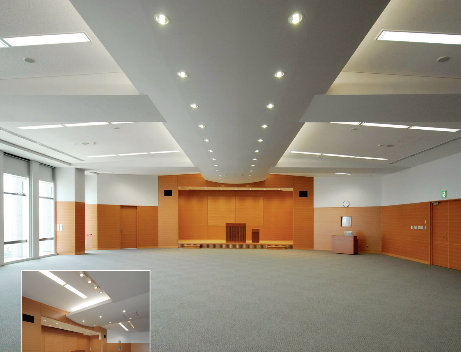
6階の講堂（防災センター）の照明：防災センターの機能を確保しつつ、多目的に利用できるよう下がり天井とした中央部の天井に蛍光灯ダウンライト、下がり天井側壁に間接照明、左右の天井には32WHf蛍光ランプ2灯用埋込器具ルーバ付を採用
