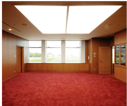
市長応接室の照明：32WHf蛍光ランプトラフを組込んだ光天井（照度センサによる初期照度補正制御）を採用
