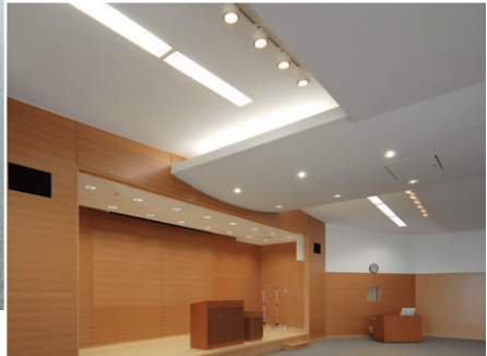
6階の講堂（防災センター）の照明：防災センターの機能を確保しつつ、多目的に利用できるよう下がり天井とした中央部の天井に蛍光灯ダウンライト、下がり天井側壁に間接照明、左右の天井には32WHf蛍光ランプ2灯用埋込器具ルーバ付を採用
