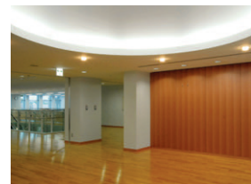
2階ホールの照明：円形状の折り上げ天井に蛍光灯器具による建築化照明
