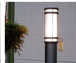
外周照明に電球色の庭園灯を配置し、温かみのある雰囲気になっている
