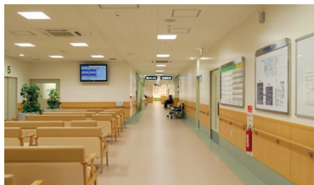
ホスピタルロード 外来診察室や検査室を連絡する。基本照明にFHP32W3灯用埋込下面開放形器具（FHR-33310K-PR9）を採用し、館内全体をムラなく照らす
