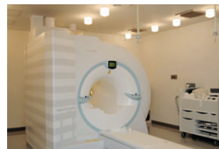
最新の1.5テスラMRIを導入したMRI撮影室。ホワイトランプ60W防湿・防雨形直付器具を20台配置
