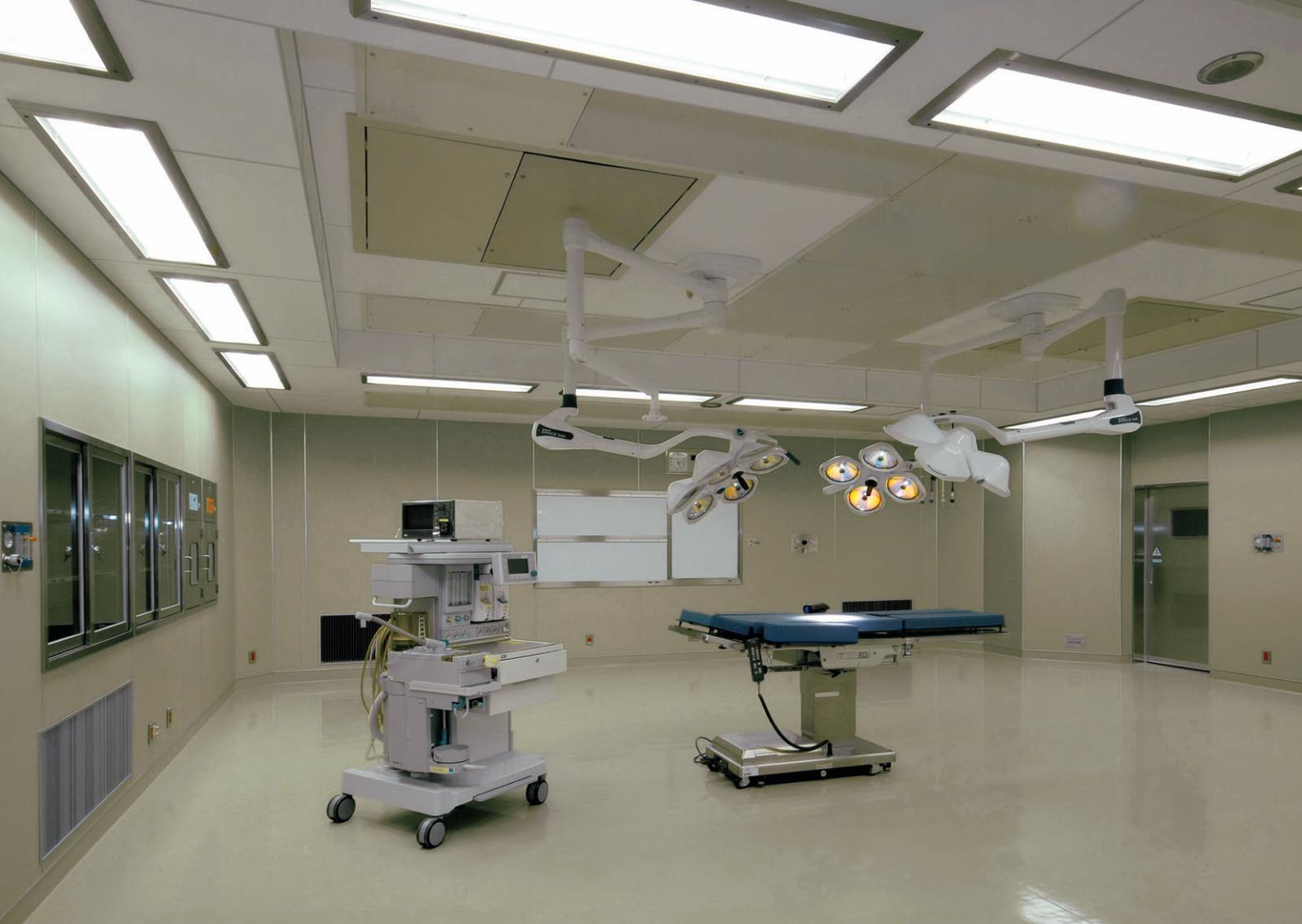
手術室(清浄度クラス100)の照明 気密性・密閉度の優れた特注のクリーンルーム用器具(2灯用)を手術台を囲むように口の字形に配置
