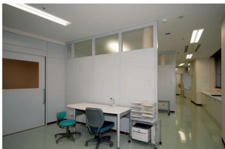
診察室の照明 2灯用埋込器具カバー付（FHF32W）を採用し、眩しさを抑制
