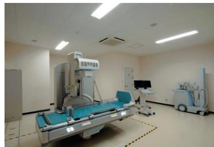
検査室の照明 2灯用埋込器具調光形バツフル付（FHF32W）を採用し、コントロールで25%～100%調光
