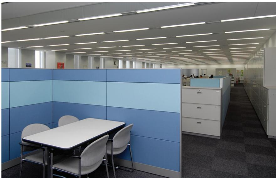
8階オフィスフロア執務室((株)東芝 四国支社)の照明 システム天井用32WHf蛍光ランプ1灯用調光器具を採用。初期照度補正制御、昼光利用制御で省エネを図りつつ、適正照度を確保
