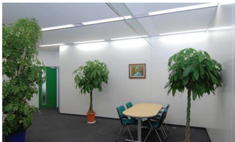
8階フロア打合せコーナー((株)東芝)の照明 システム天井の設備ラインに照明器具のほか照度センサ、空調吹出口等を集約設置
