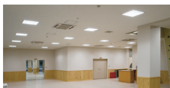
トレーニング室 FHP45W4灯用ルーバ付スクエア器具を等間隔に配置
