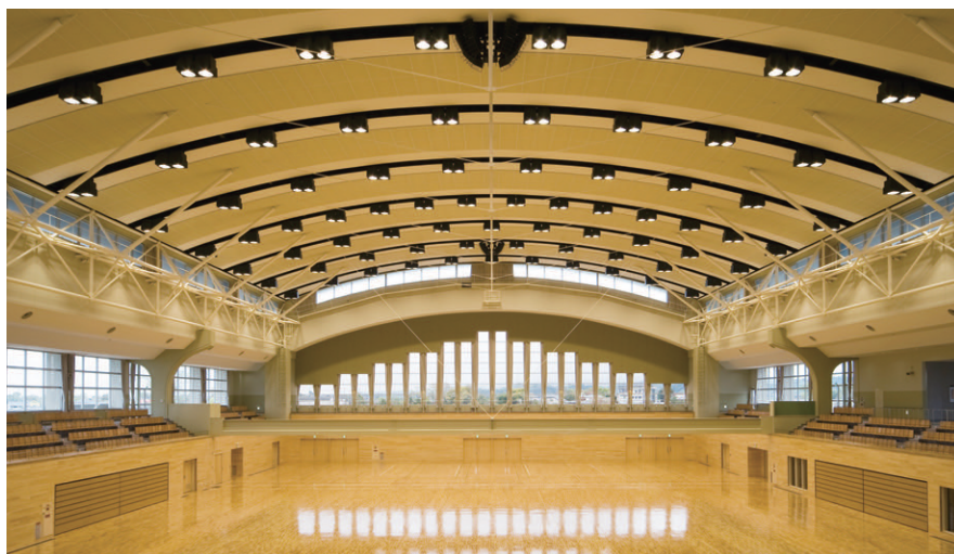
アリーナ全景 手前側がメインアリーナで奥側にサブアリーナを望む。なだらかに弧を描く黒色トラスに塗装色を合わせた、1kWメタルハライドランプ搭載特注2灯用バンクライトを分散配置
