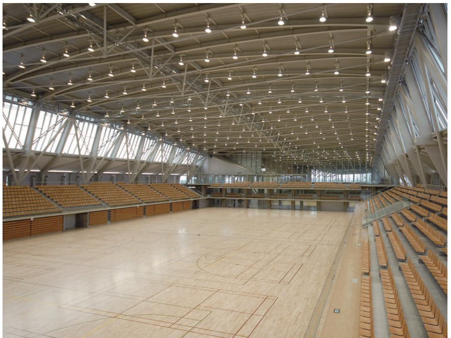
メインアリーナの照明 床上約21mの高さに1000Wメタルハライドランプ高天井用反射笠器具を分散配置。両サイド1列ずつには可変形制御器具(M1500W)を採用
