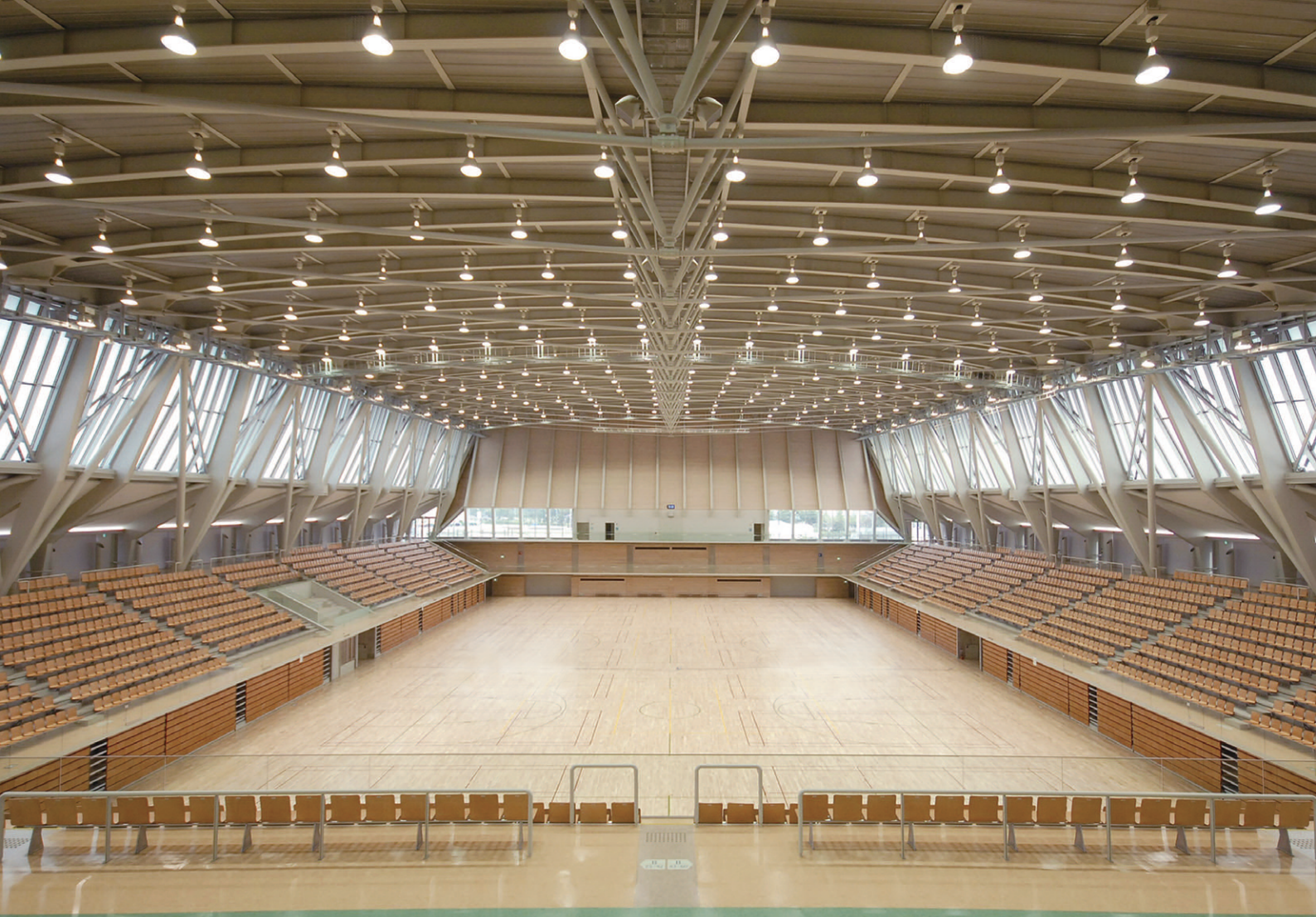
3階から望むメインアリーナの照明 反射笠器具全点灯時で1200lx、両サイドの変形制御器具の点灯を加えると1500lxが得られている
