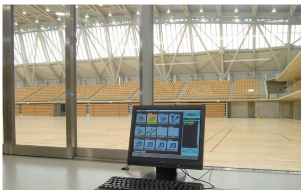
可変形制御器具の操作卓
