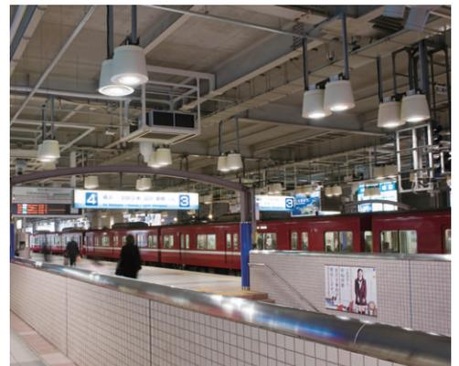
上りホーム階段付近 階段上方からの明るさが確保されて階段面の照度が得られるようになる
