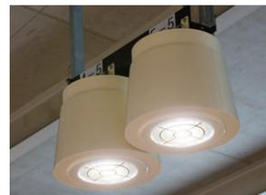
照明器具アップ 銅板を特殊成型した灯体にプレアマルチ器具を組合せる
