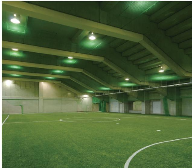
2ヵ所に設けられている室内練習場 防球ネット上部に700W金属ハライドランプ 高天井用反射笠器具を均等配置 (器具近くのネット上部には点検用チャックを装備)
