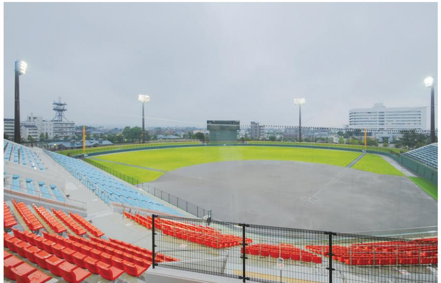
球場のナイター照明 2kWショートアーク形メタルハライドランプ投光器（ダイナビーム3）搭載の照明塔6基を使用
