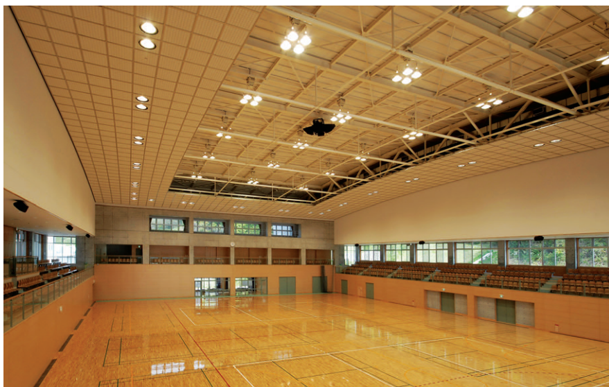
アリーナの照明 中央のスケルトン天井部分にMF1kW 高天井用反射笠器具4台セットを、その周囲の天井張りにはMF1kWダウンライトを設置。照明制御装置により各競技レベルに適切な照度を確保
