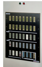
照明制御装置
