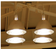
アリーナの照明 中央のスケルトン天井部分にMF1kW 高天井用反射笠器具4台セットを、その周囲の天井張りにはMF1kWダウンライトを設置。照明制御装置により各競技レベルに適切な照度を確保
