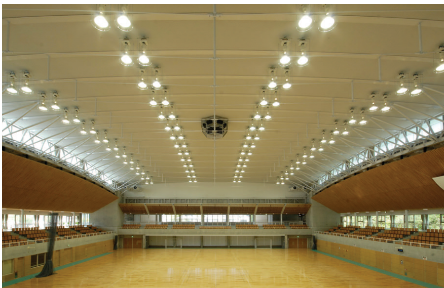
アリーナ全景 大分県産の杉材を遮音板に使用した特徴的なアリーナ全景を望む。700Wネオハイドランプバラスト付ランプホルダー用反射笠を2台1組で分散配置
