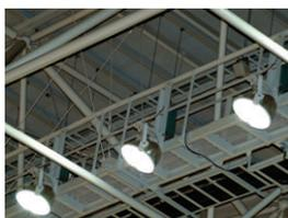
キャットウォークに設置した1kWメタルハライドランプ投光器
