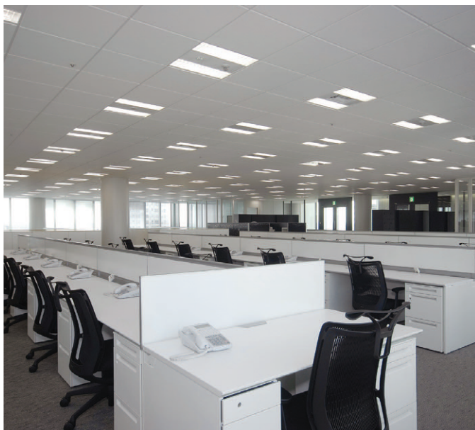
オフィス基準階 照明制御機能として人感センサ+明るさセンサを設けて不在時にはエリア区分で消灯。省エネと快適性の両立を図る
