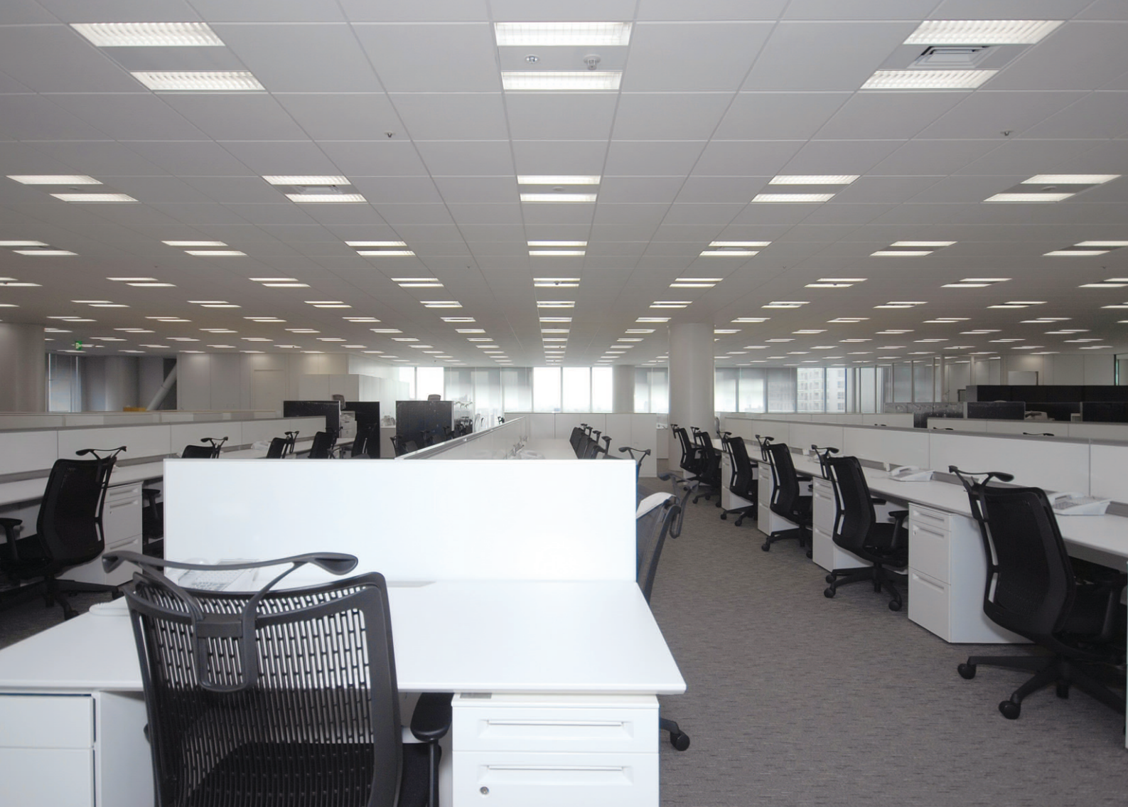
オフィス基準階 600mm用ネオグリッドスクエアタイプシステム天井用器具を基本照明として採用。FHP45W2灯用白色バツフル付器具を1800ピッチで等間隔に配置しオフィス空間を形成
